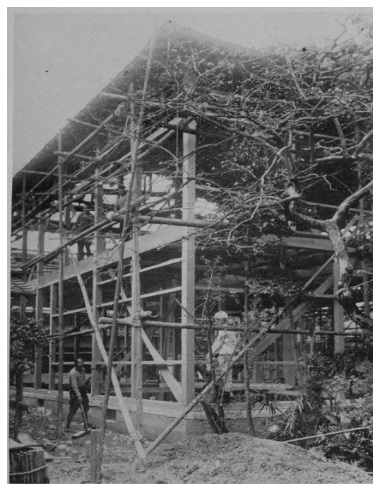
写真7 工事中の和敬学園新園舎(『衆善』昭和9年5月号)
