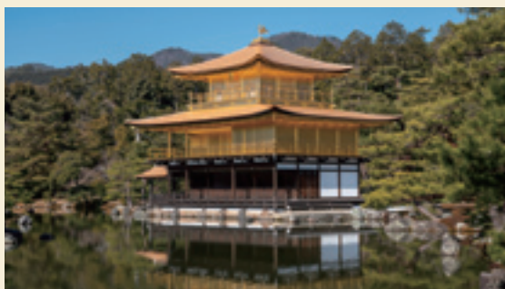
屋根葺替を終えた舍利殿
