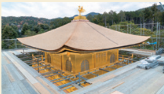
素屋根を外した第三層
