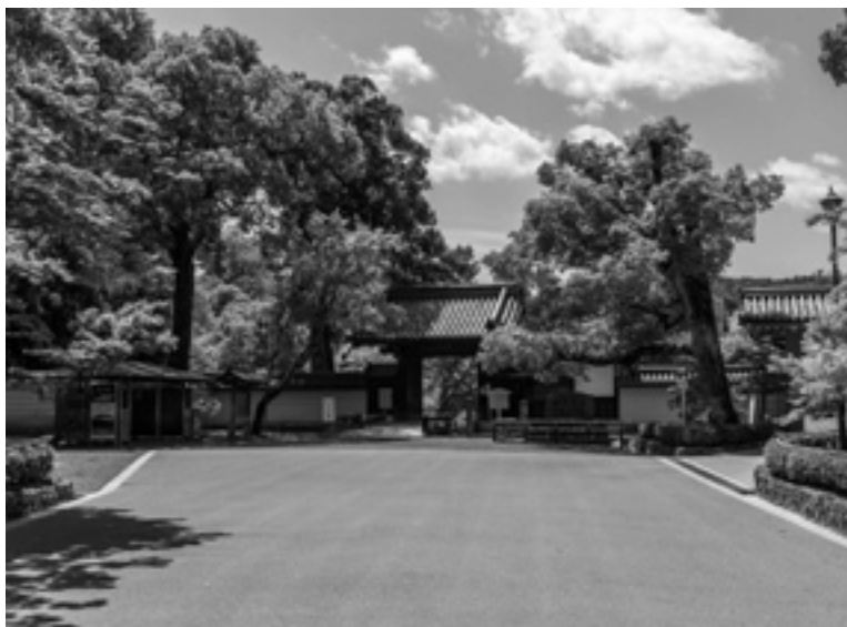
工事後の参道
