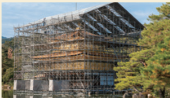
足場解体中の様子
