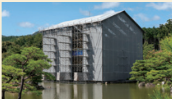
工事中の舍利殿
